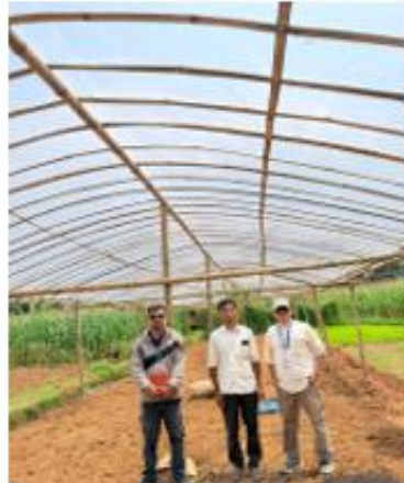
चापाकोट नपा-१, बस्याल कृषि फर्म, बाँसको टनेल निर्माण
