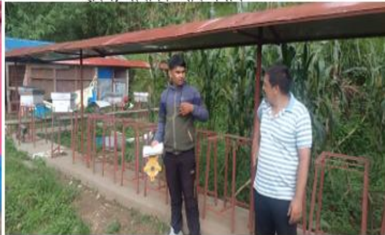
अर्जुनचौपारी-१० काउले, १०० मौरीघार मौरीपालनका लागि सहयोग-संरक्षित संरचना निर्माण-१०० मी
